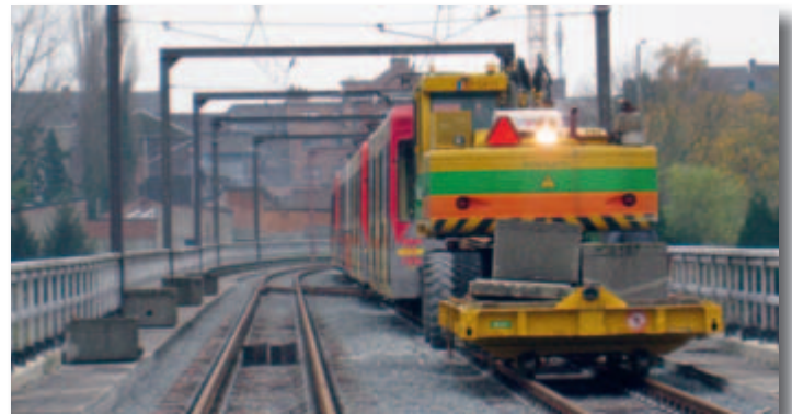
BAM Rail arbeitet am Bahnhof Zwolle (im Norden der Niederlande) während einer 48-stündigen Stilllegung des Bahnverkehrs an der Oberleitung. ●
