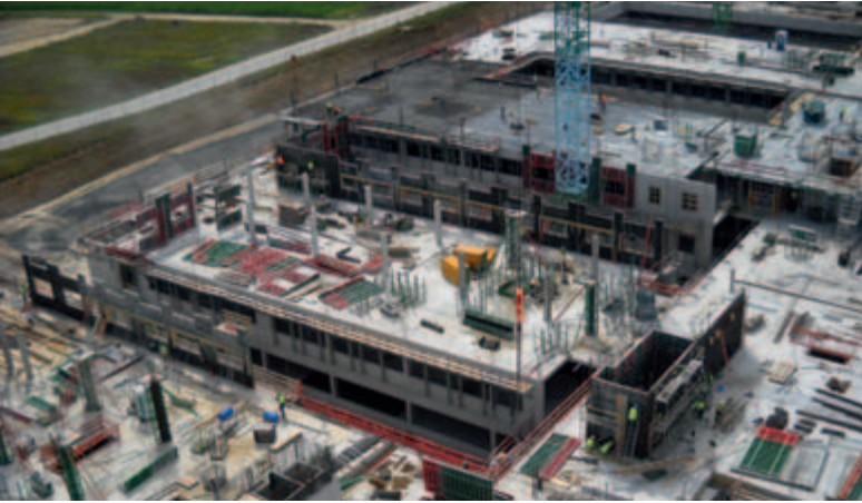
Beim Neubau des Schwarzwald-Baar-Klinikums trägt ein geänderter Ablauf beim Aufbau der Wandschalungen an den Lochfassaden zu mehr Sicherheit bei.
