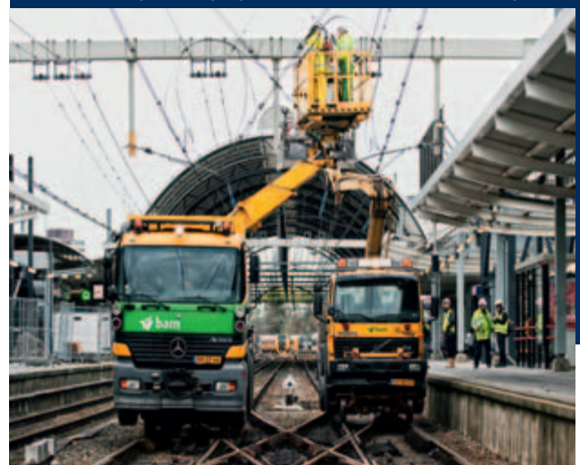
BAM Rail arbeitet am Bahnhof Zwolle (im Norden der Niederlande) während einer 48-stündigen Stilllegung des Bahnverkehrs an der Oberleitung. ●
